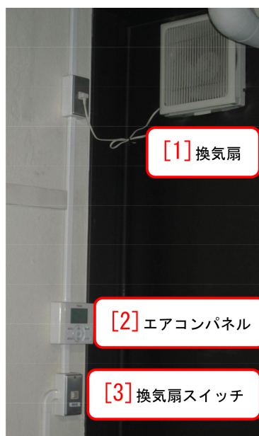
図 E.5 換気扇が回っていることを必ず確認する
